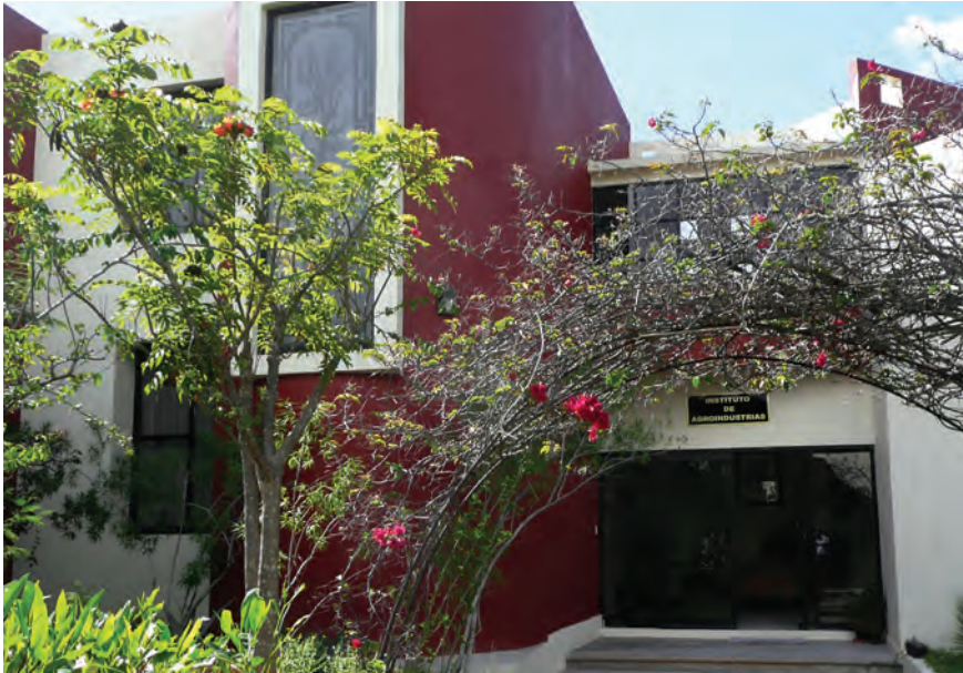
Instituto de Agroindustrias, acceso principal.
