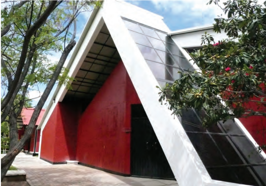
Talleres de Maderas y Metalmecánica.
